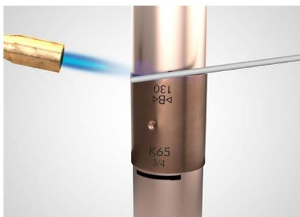
2. Verbindung erhitzen und Flussmittel auftragen.
